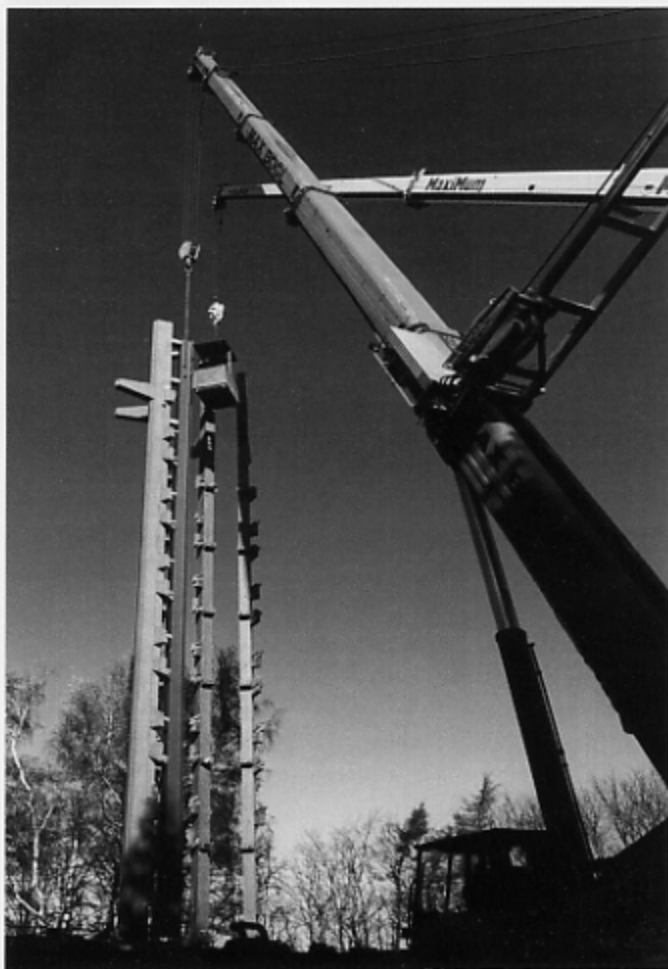
Die Säulen werden aufgestellt
