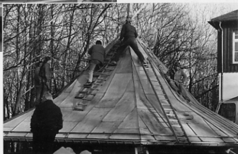
Die Dachkonstruktion – Fertigung am Boden
