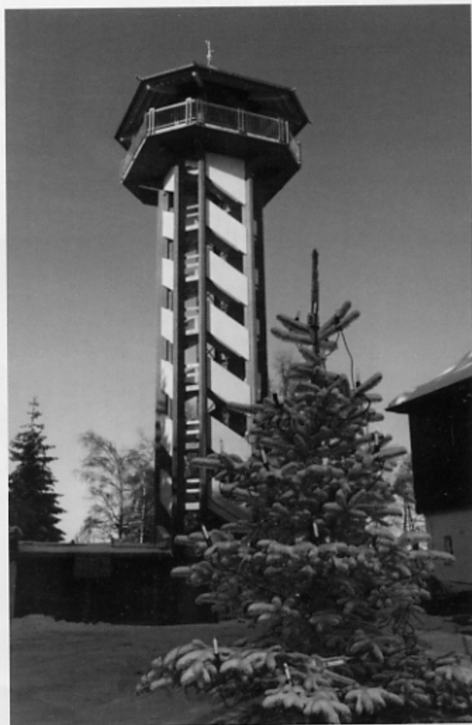
Der Christbaum steht – der Turm-Rohbau auch!
