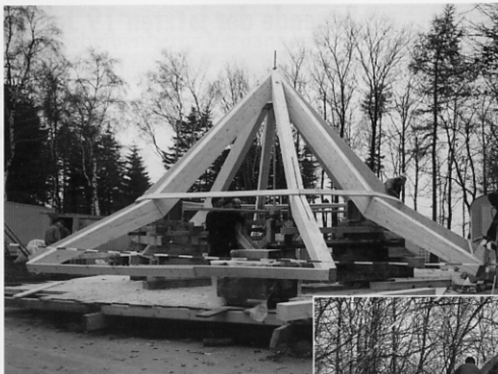
Die Dachkonstruktion – Fertigung am Boden
