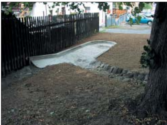
Einlaufbauwerk im Stadtpark
