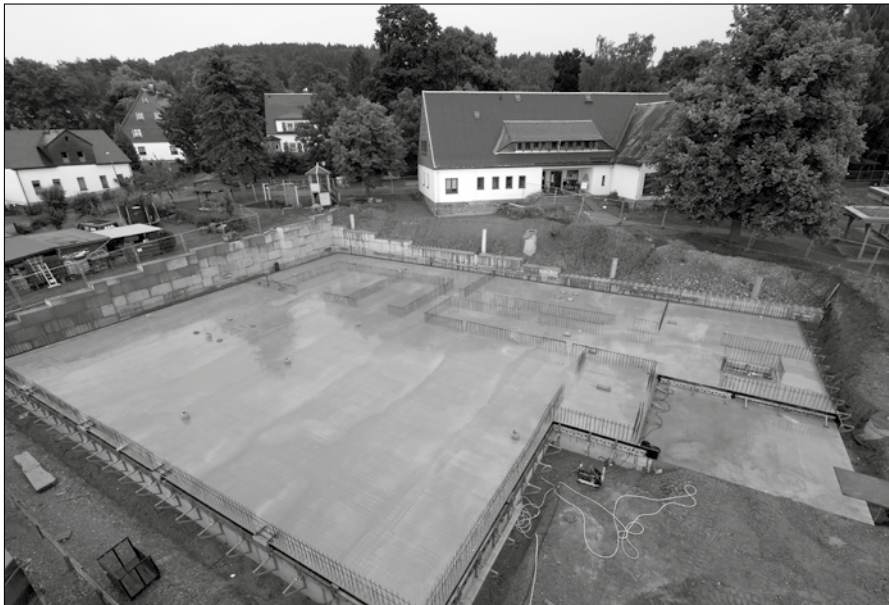
Fotos: Bodenplatte Bildungs- und Begegnungsstätte
