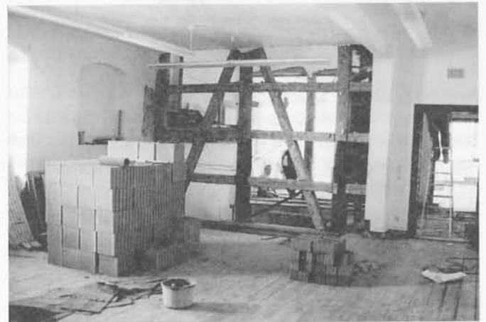
☉ Das Musikzimmer während der Bauphase
