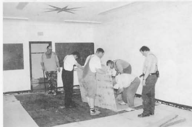
☉ Kameraden der Freiwilligen Feuerwehr Scheibenberg entfernen Fußbodenbelag.
