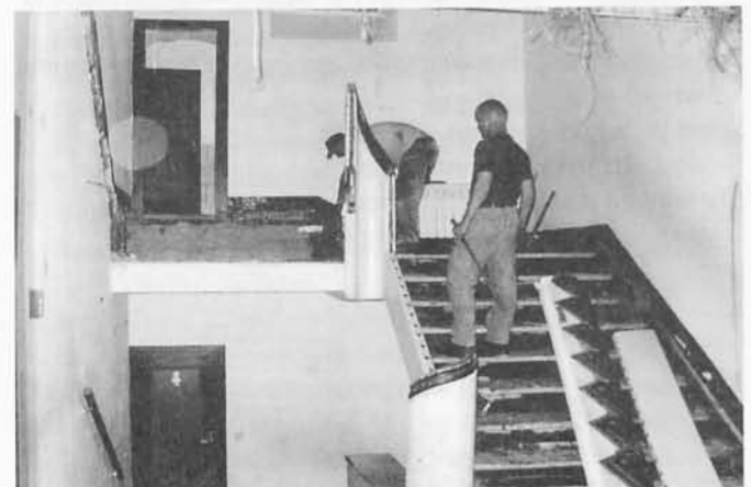
☉ Die Firma THS schafft Platz für die neue Treppe.
