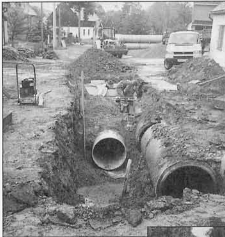
Parallel zum alten Wasserkanal wurde ein neuer verlegt.
