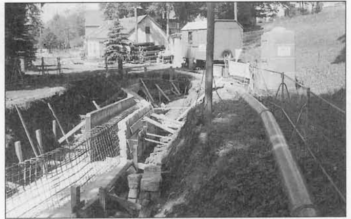
Befestigung der Dorfstraße durch eine Stützmauer
