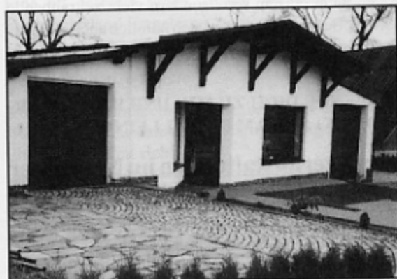
Fliesenverlegung Götz, Verbindungsstraße
