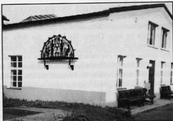
Illing & Schilling GmbH, Elterleiner Straße
