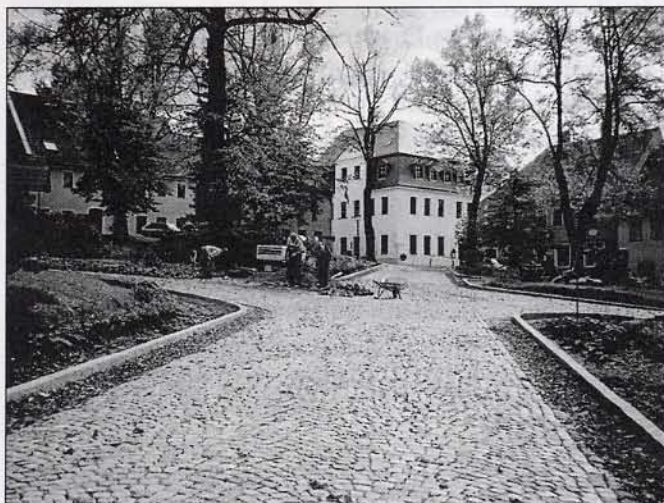
Unser Marktplatz – Sanierungsarbeiten
