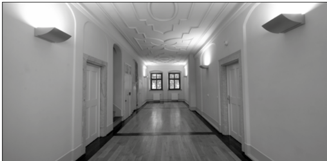
Der Flur im 1. Obergeschoss konnte wieder komplett geöffnet und freigelegt werden.
