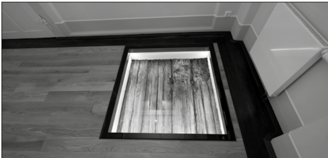
Bodenverglasung mit Blick auf die historischen Deckenbalken. Es sind Verkohlungen sichtbar, vermutlich Spuren eines Stadtbrandes.
