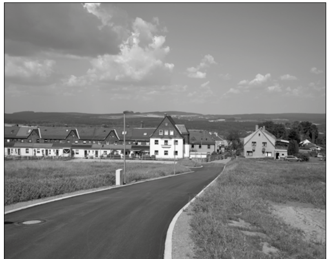
Blick entlang des neu entstandenen Teilstücks der Goethestraße vom Schnitzerweg aus in Richtung Schillerstraße.
