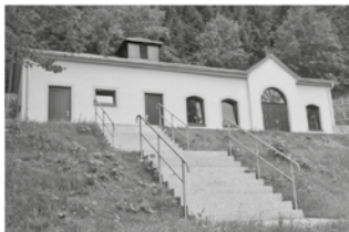
Sanierung der Trauerhalle in Niederschmiedeberg
