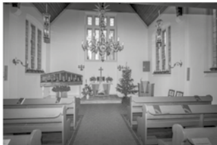
Innensanierung der Friedhofskapelle Hilmersdorf
