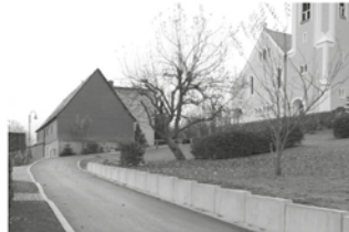
Ausbau des Kirchsteiges in Neundorf
