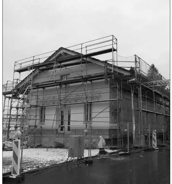
Medienversorger des Digitalen Testfeldes (ehemaliger Güterboden)
