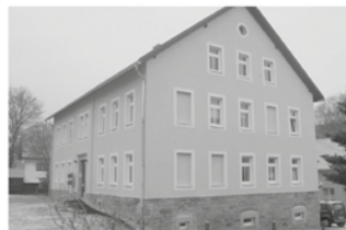
Fassadensanierung in Sehmatal-Sehma
