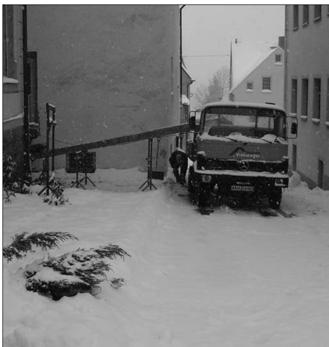
Die Bauarbeiten im Rathaus haben begonnen.
