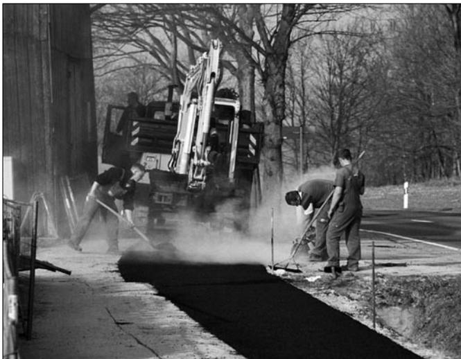
*Ausbesserung des Fußweges nach Kanalarbeiten*
