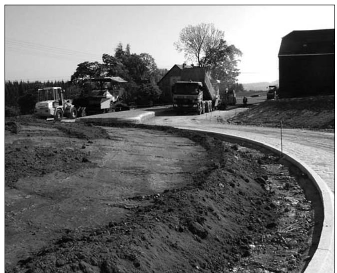
Bauarbeiten am neuen Kreisverkehr S258 in Scheibenberg
