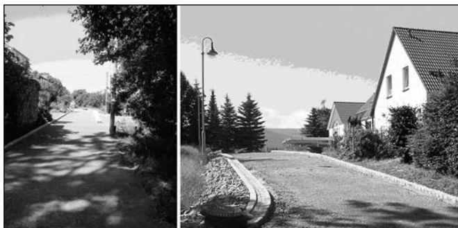
Fotos: Ausbau der Straße Am Abrahamstollen
