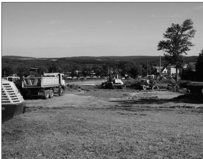
Staatsstraße 258, Ortsumgehung Scheibenberg - Die Baumaßnahme läuft auf Hochtouren.
